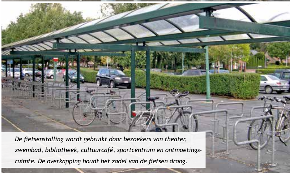
Fietsen kunnen met het frame en de wielen aan de stalling bevestigd worden.
