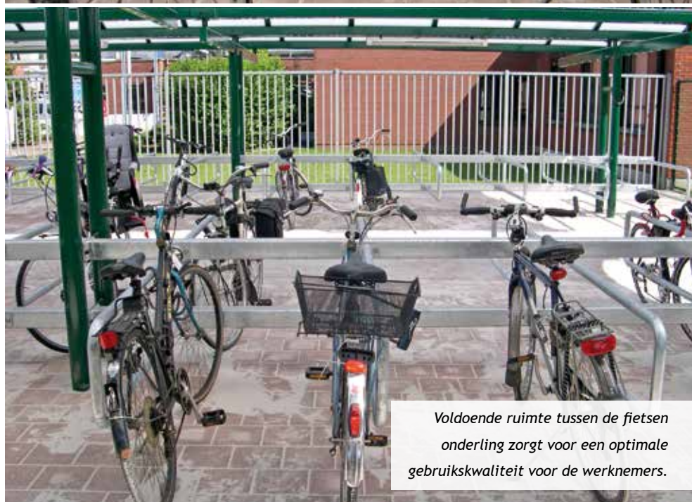
De ruimte tussen twee beugels bedraagt 1 meter. Daardoor kunnen ook fietsen met fietstassen en stuurmandjes comfortabel en vlot gestald worden.
