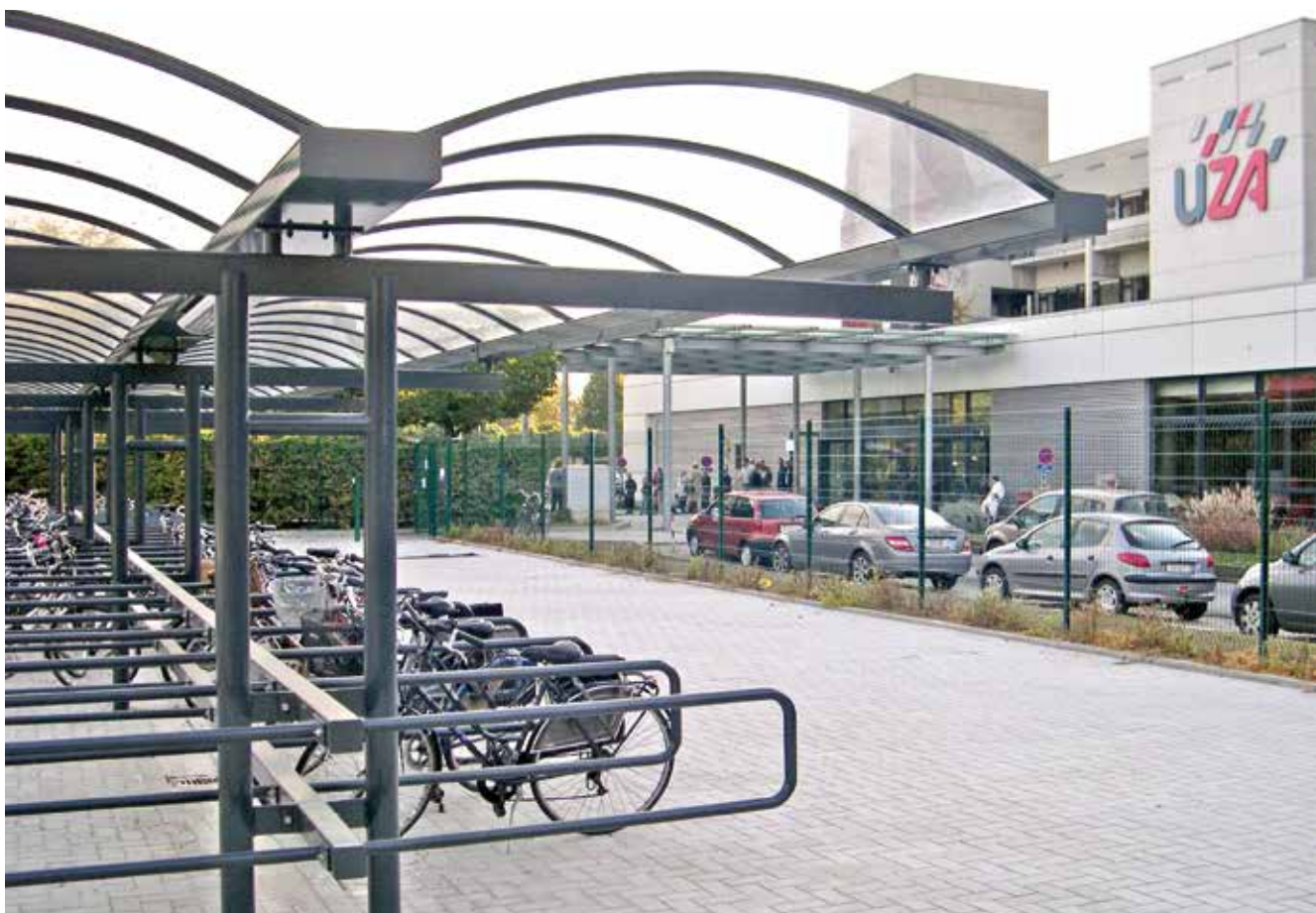
De fietsenstalling ligt vlak bij de ingang van het ziekenhuis. Ze is overdekt en verlicht voor de gebruikers.
