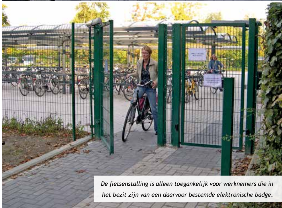
Voldoende ruimte tussen de rijen onderling zorgt voor een optimale gebruikskwaliteit voor de werknemers.
