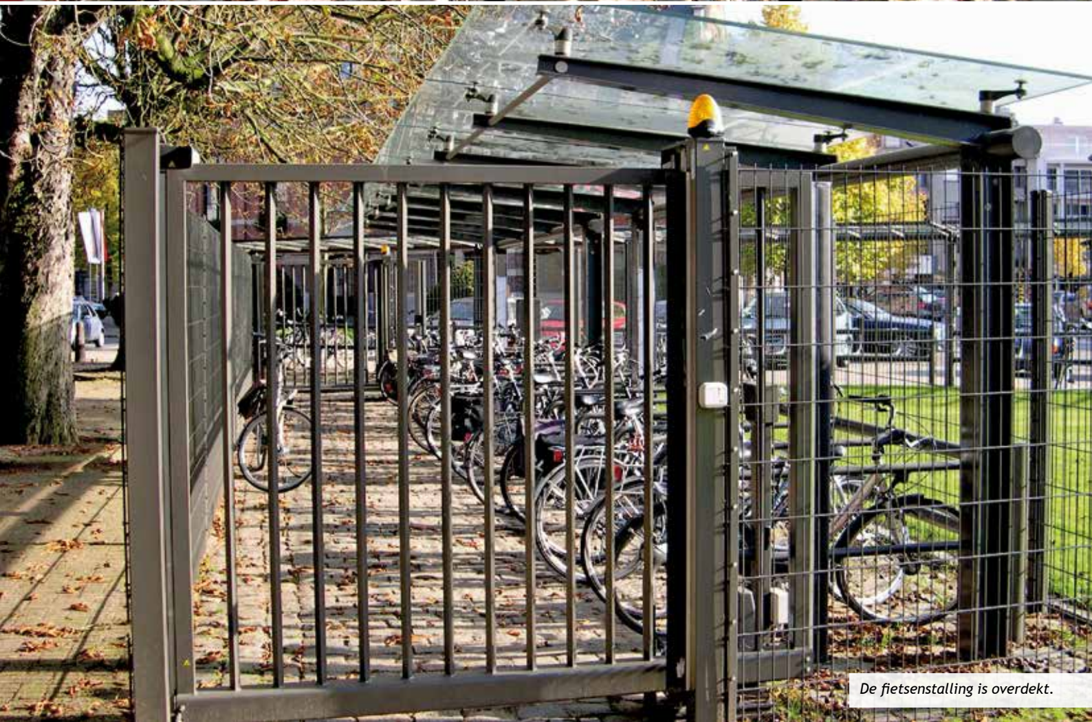
In de fietsenstalling voor het gemeentepersoneel is er voldoende ruimte tussen de beugels (0,85 meter), zodat per beugel twee fietsen gestald kunnen worden.
