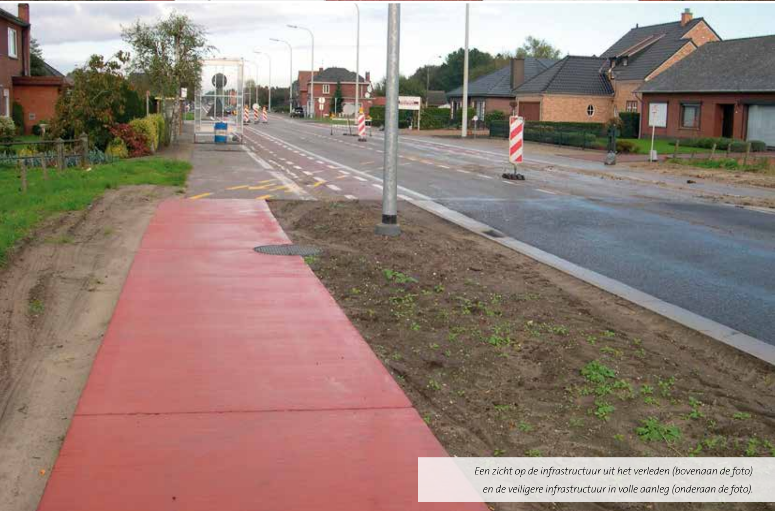
Ook op de brug over het Kempische Kanaal wordt de veiligheidsstrook tussen fietspad en rijbaan behouden.
