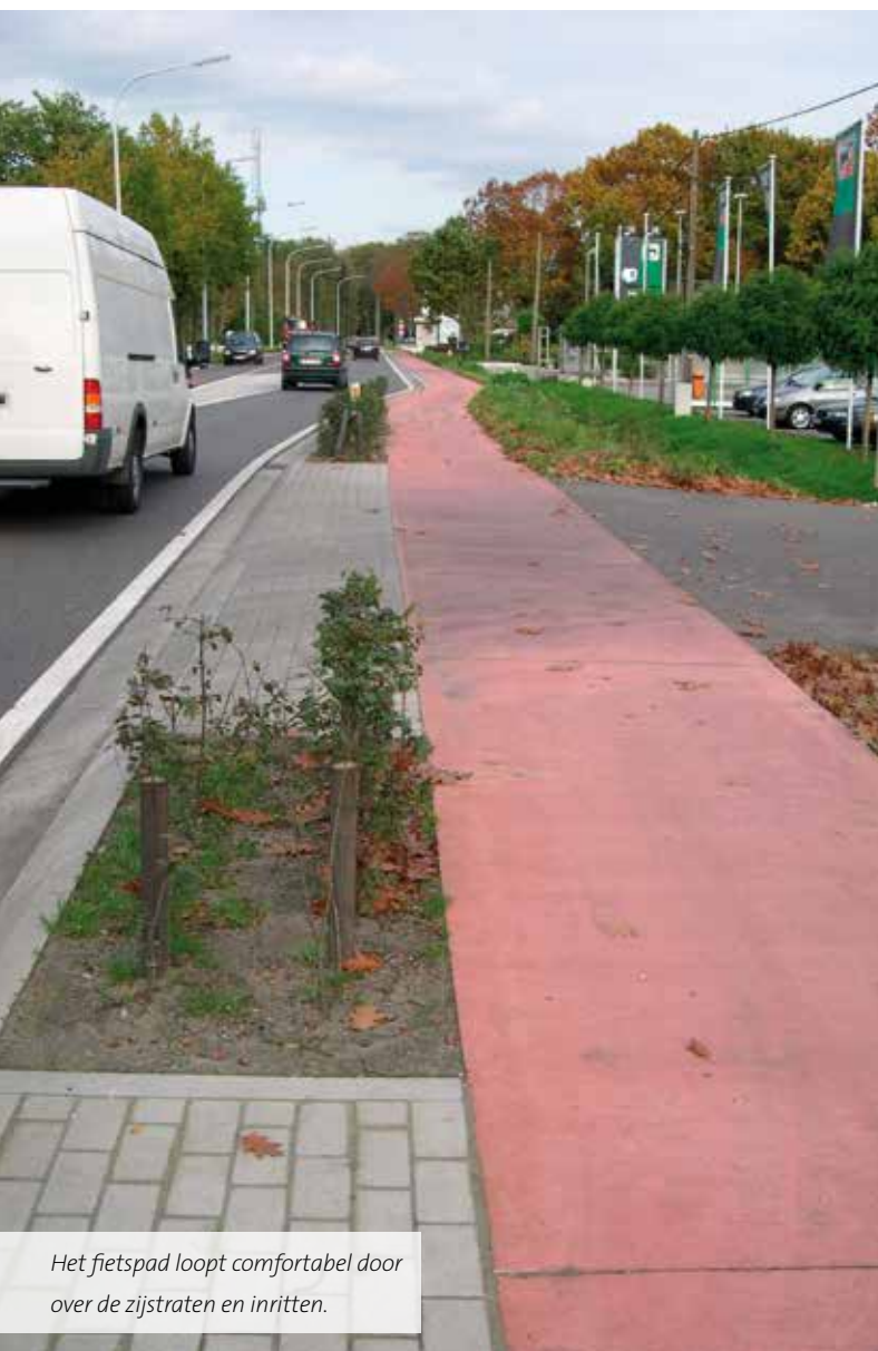
De afscheidingszone met haagje wordt op regelmatige afstanden onderbroken om fietsers toe te laten de overkant te bereiken.
